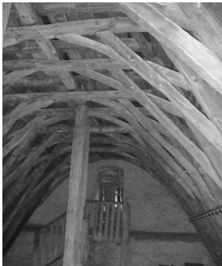
*Das Dach des Kirchenschiffes wurde im Jahr 1912 renoviert. Die hintere, erhöhte Türe führt in den Glockenturm. Das Gebälk im Kirchenschiffsdachstuhl ist in sehr filigraner Arbeit als umgedrehter Schiffskiel angefertigt und ist in unserer Umgebung einmalig. Er besteht bereits seit etwa 550 Jahren unverändert.*
